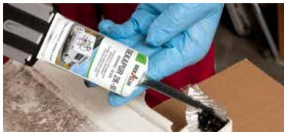
Durch die hervorragende Verarbeitungskonsistenz eignet sich unser DEKAPUR 2K-90 ideal zum Reparieren, Füllen, Dichten und Kleben. Nach der Aushärtung bildet er eine feste Kunststoffmasse. Das 2K-Doppelkammersystem sorgt stets für kontrollierte, schnelle Durchhärtung und macht den Klebprozess fast unabhängig von Umgebungstemperatur, Luftfeuchtigkeit sowie Schichtdicken.
