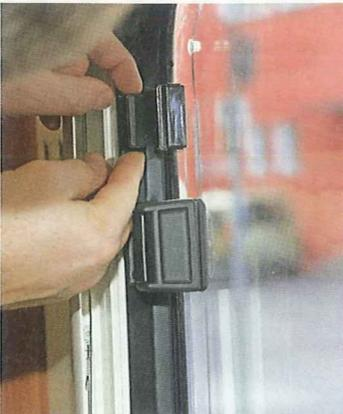
**9** Mit einem Abstand von bis zu 20 Millimeter zueinander werden Sendeeinheit und Magnet montiert.
